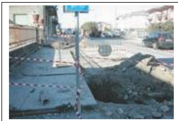
Situazione non regolare, il solo nastro non è sufficiente per proteggere dalla caduta nello scavo
