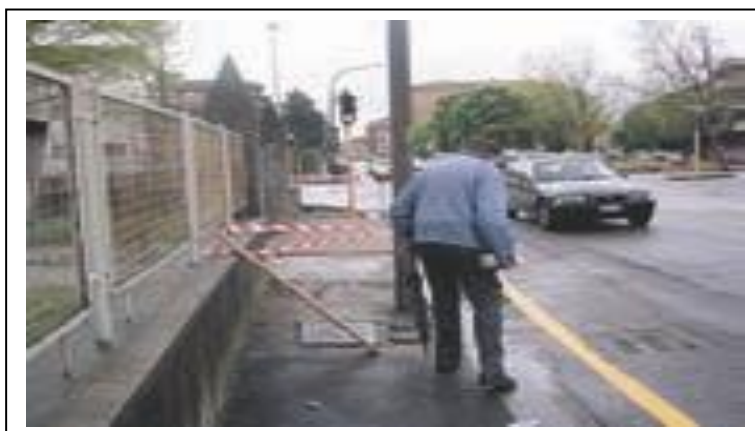
Situazione non regolare. L'occlusione del marciapiedi costringe i pedoni ad andare in carreggiata strada protezione.
